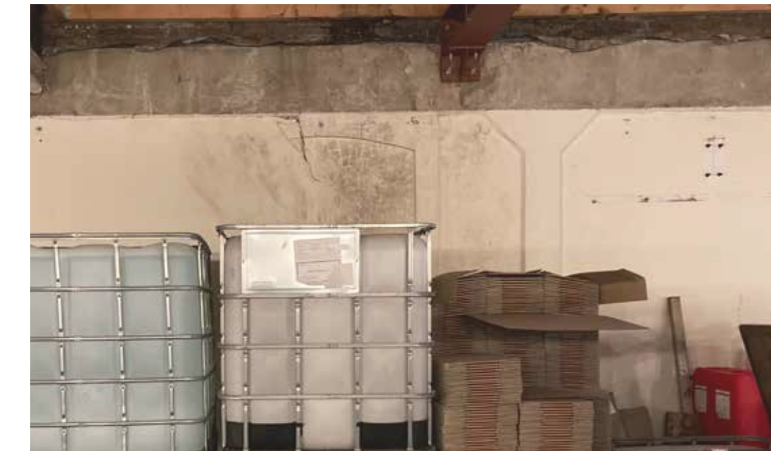
Kantoor 1912 overblijfselen gevel/bestonstructuur, 2021
