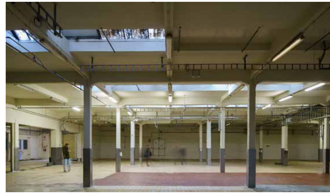
Fabriekshal interieur zuidelijk deel, 2015
