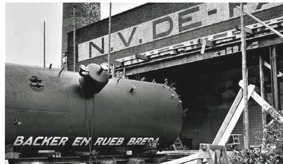
Plaatsen van ketel, omstreeks 1960
